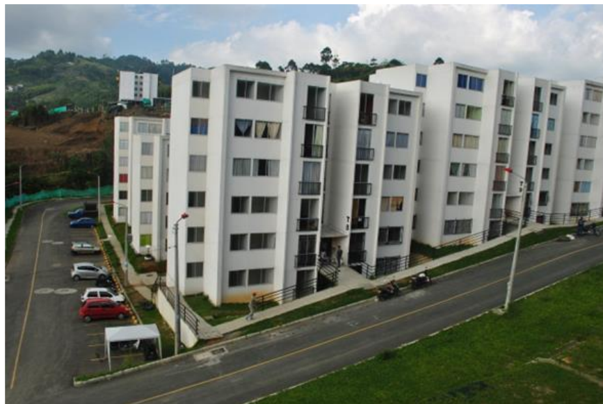
Multifamiliares Los Juncos
