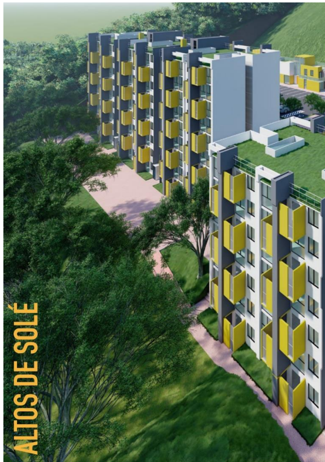
Proyecto de Vivienda Altos de Solé
