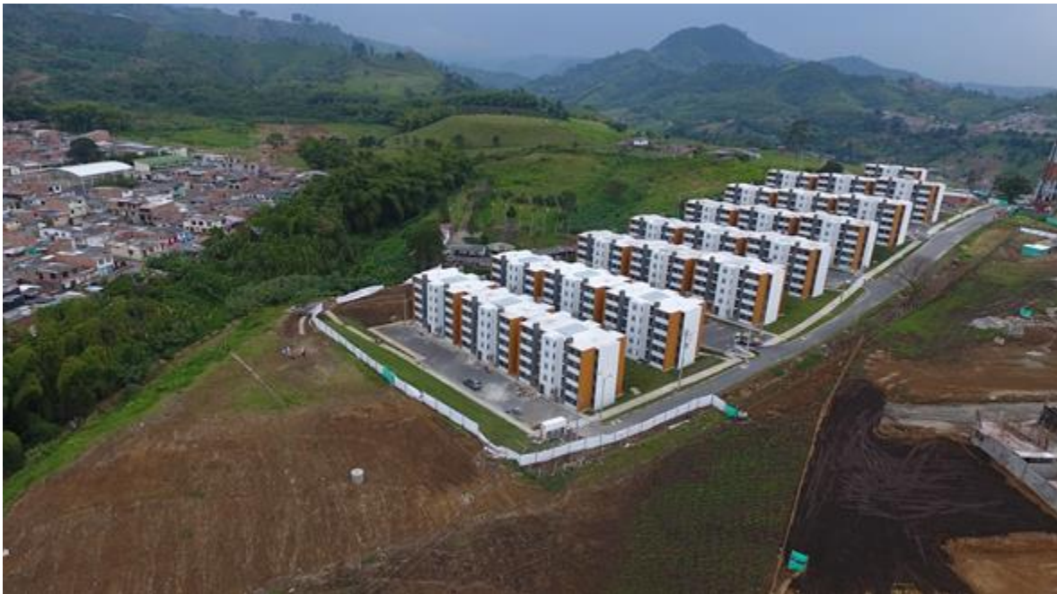
Multifamiliares La Giralda
